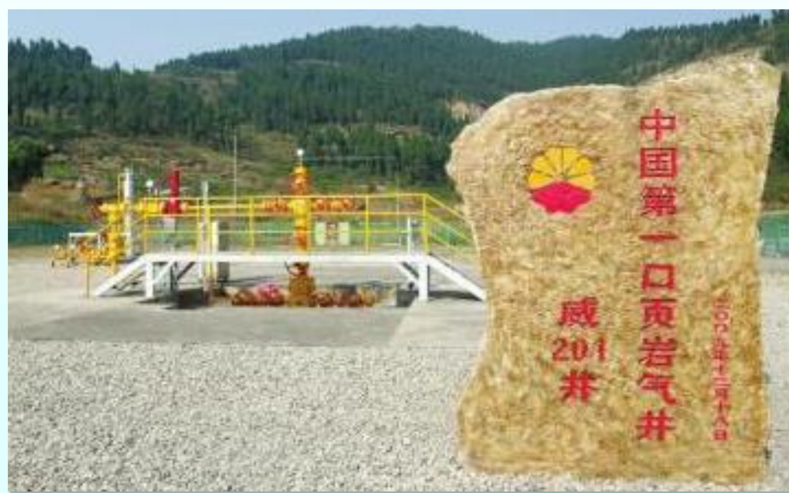
页岩气井施工现场
