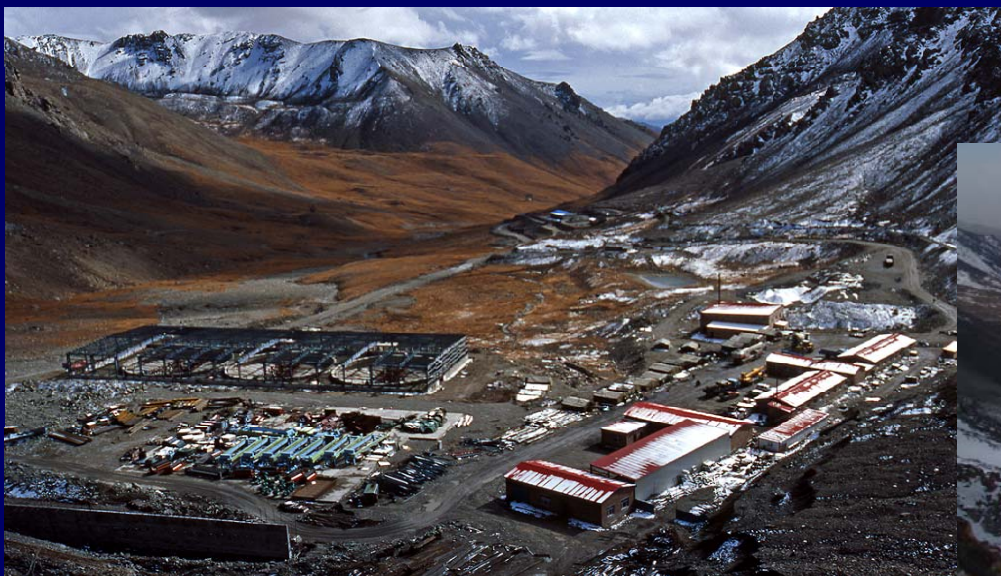
智博铁矿矿山建设
