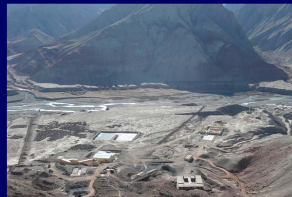
建设中的萨热克铜矿选厂
