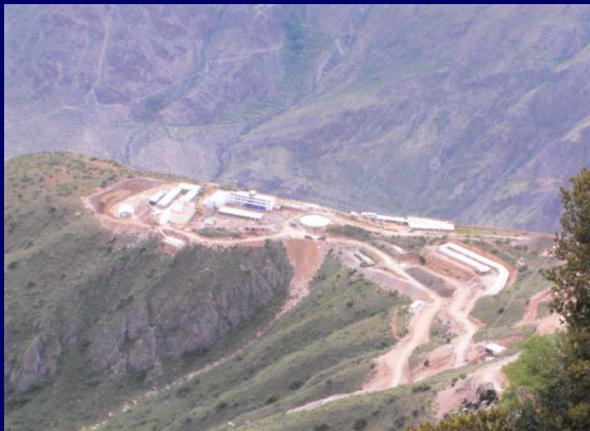
矿山建设工地
