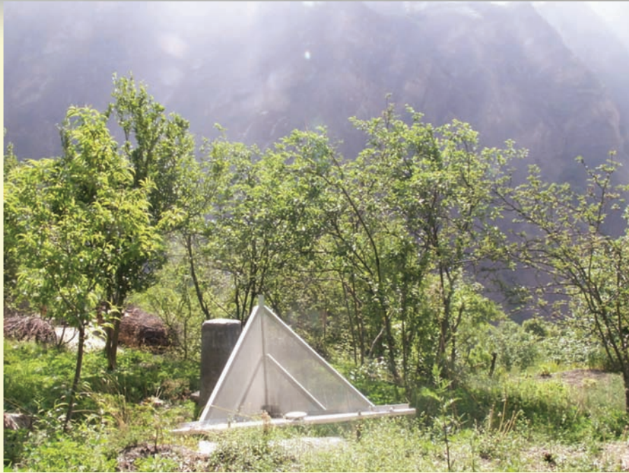
甲居滑坡上安置的角反射墩、GPS 监测墩及深部位移监测孔
