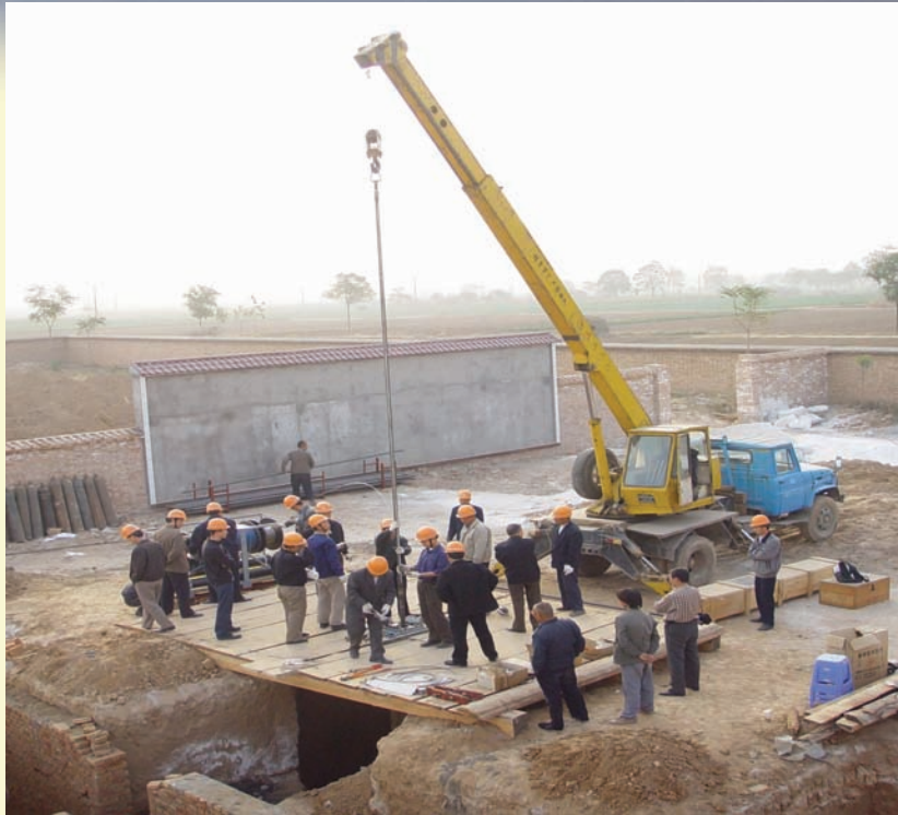
利用 Packer 系统进行深层地下水取样
