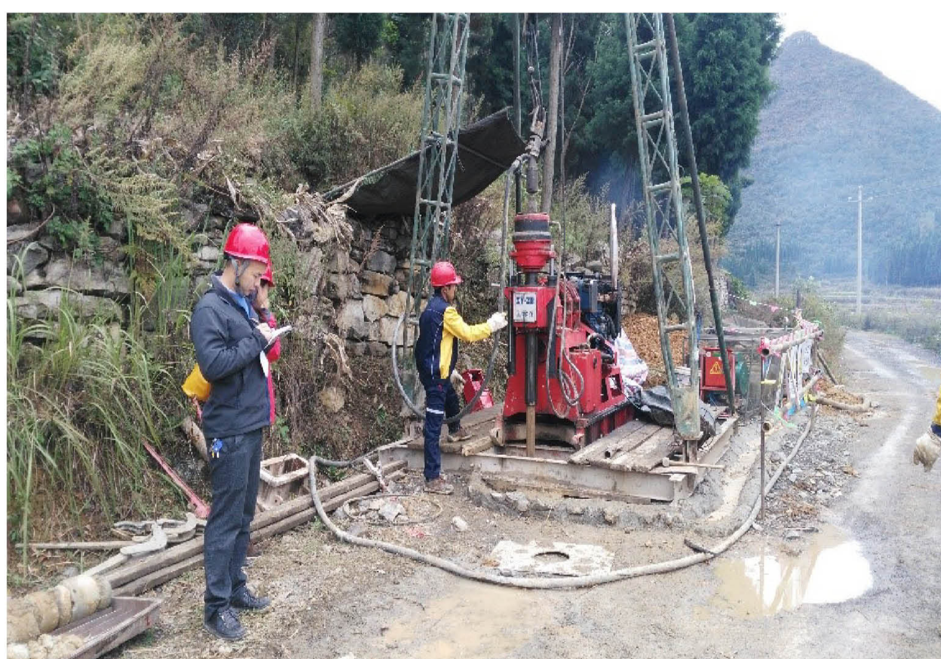
地下水监测工程监测孔施工现场
