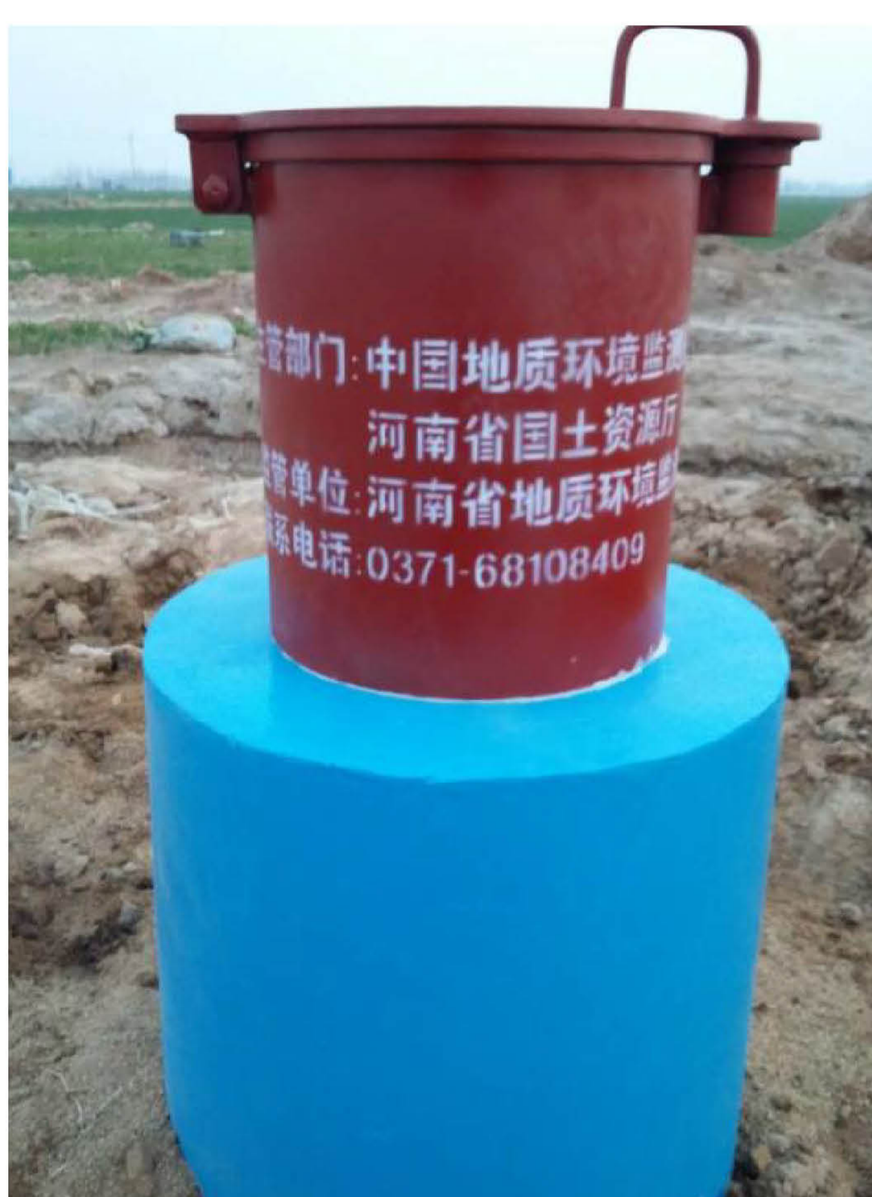
竣工的地下水自动化监测孔
