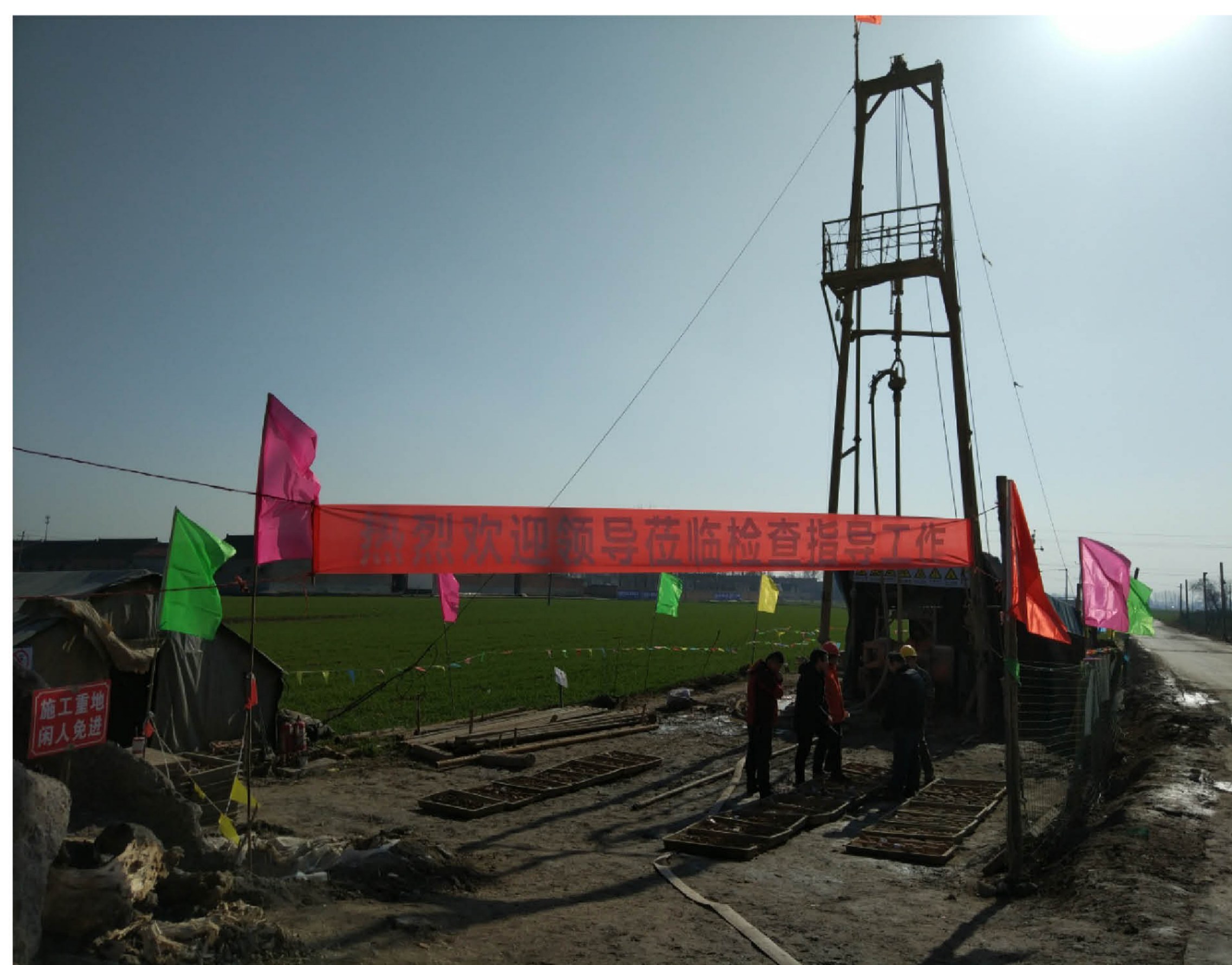
省地下水监测工程监测孔施工
